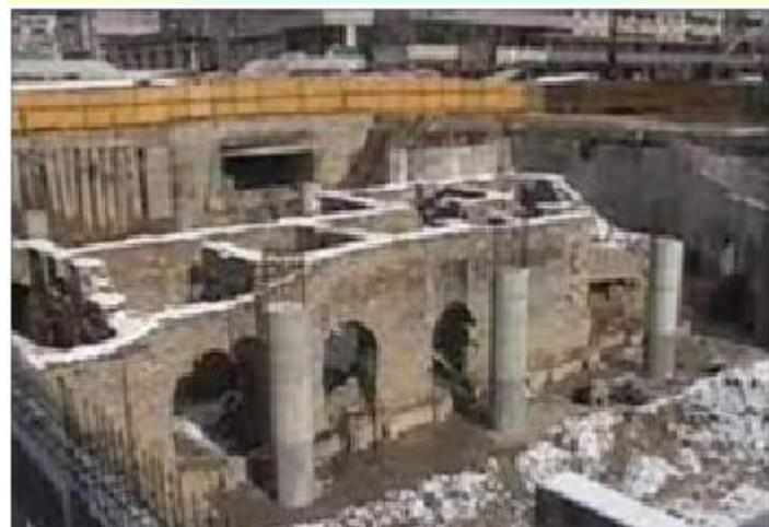
Ruinele castelului Roznovanu de la Stânca-Costești (încercări de renovare)
